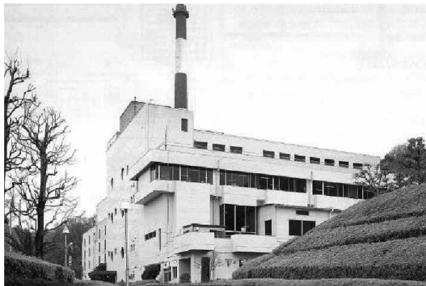
▲昭和51年に建築された現在の清掃プラント（ごみ焼却施設）
