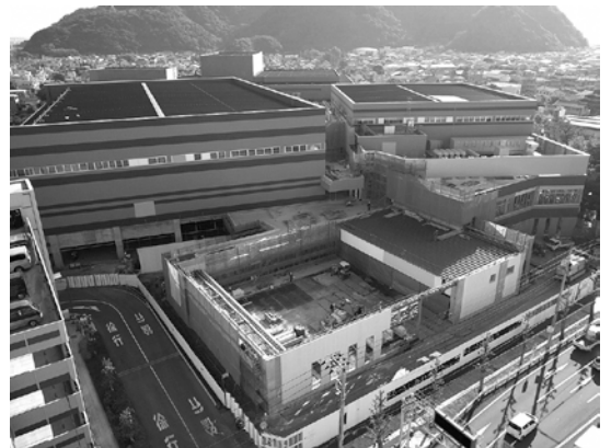
▲建設が進む総合体育館 (令和4年11月11日現在)
