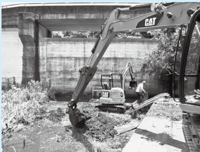
▲雨水貯留池に堆積した土砂の撤去
