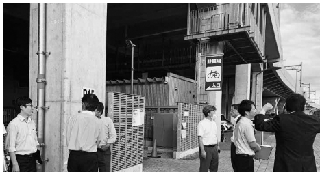
▲旭川駅高架下の利用を視察（旭川市）
