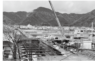
▲整備が進められている大平江川排水機場
