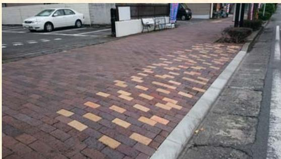
割れてしまったブロックの補充材として類似品を用いて模様のようにしたもの
