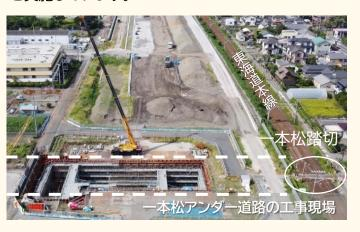
現在、東海道本線南側で、地下水を止水対策の上、深さ約9mまでの掘削が完了し、鉄筋コンクリートのボックスカルバート(箱型構造物)の築造を行っています。ボックスカルバートの築造完了後は埋戻し、東海道本線をターミナル南側に移設後、現在の線路の部分を掘削して残りのボックスカルバート築造といった順序で、段階的に工事を進めていきます。
