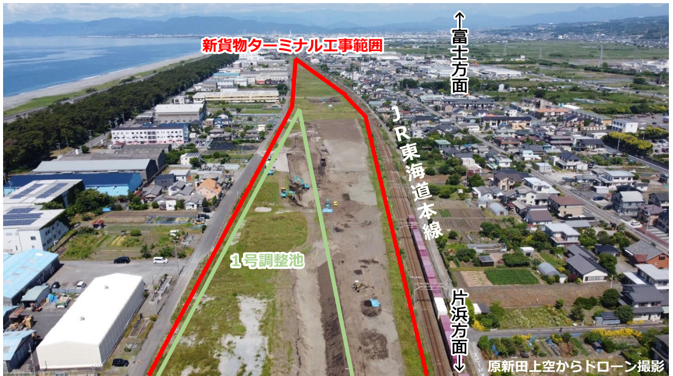
①造成工事：地面が一定の高さになるよう整地しています
