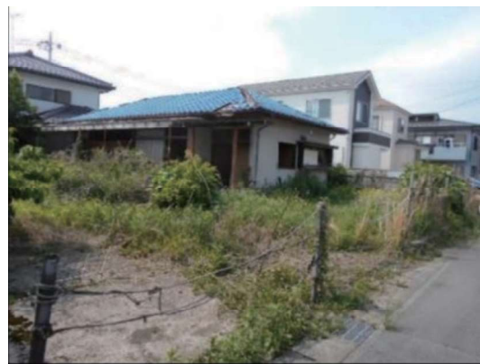
適切に管理されていない空き家等 雑草が繁茂、屋根の一部が欠損
