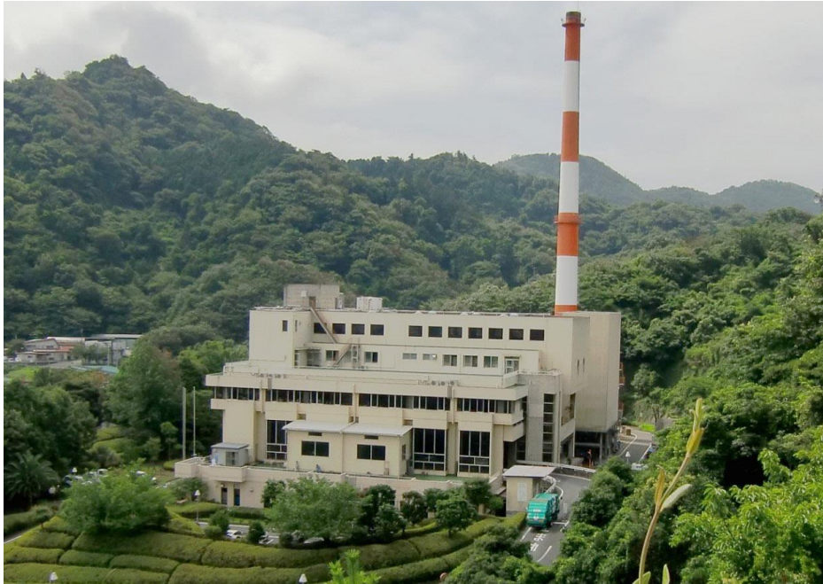
写真 2-1-1 沼津市清掃プラント
