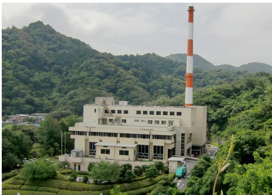
写真 2-1-1 沼津市清掃プラント
