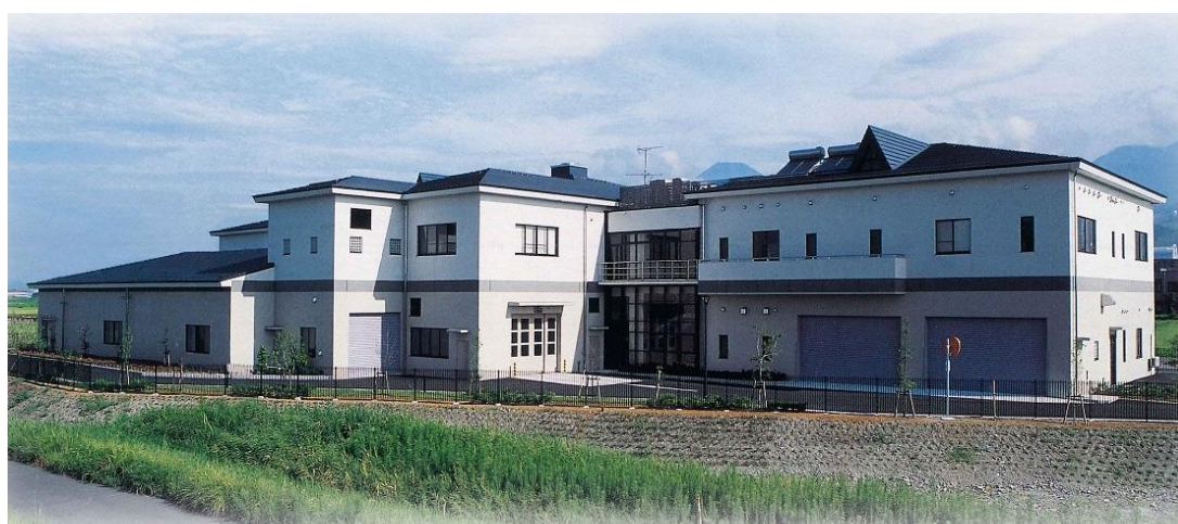
写真 3-1-1 沼津市衛生プラント（アクアプラザ）
