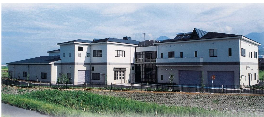
写真 3-1-1 沼津市衛生プラント（アクアプラザ）
