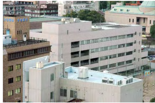
壁面の立ち上げにより屋上設備を遮へいしているとなり建物のデザイン性を高めている
