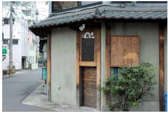
メーターボックスの扉に建物の開口部と調和した素材を用いている
