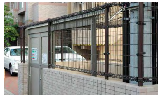
ゴミ集積所を壁で囲むことにより、周囲から目立たなくさせている。
