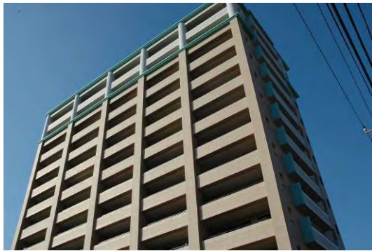
屋外階段を露出させずに、建築物と一体感のあるデザインとしている。
