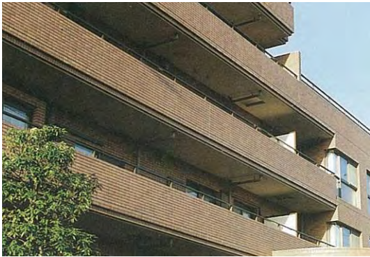
バルコニーの高さを調整し、空調室外機や物干し場を隠している。
