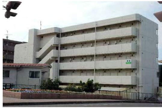
配管が外壁と同じ穏やかな色彩で統一されている建物
