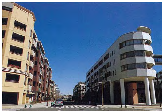
隣接する建物と高さや外観デザインに統一感を持たせ、街区単位で個性的な街並み景観の形成を行っている。
