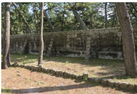
[写真 4-25] 江ノ浦寅石積塀
