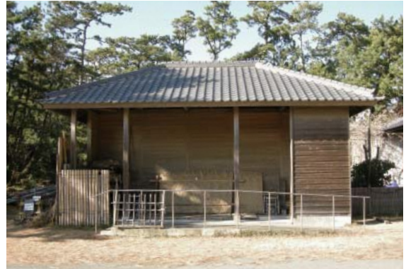
[写真 4-32] 休憩室兼倉庫
