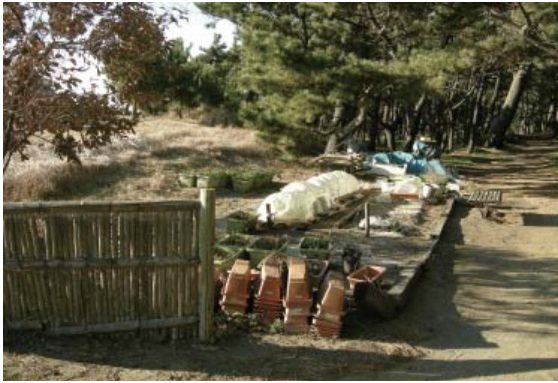
[写真 4-60] 苑路沿いへの資材の仮置き
