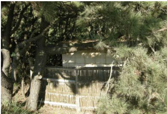
[写真 4-33] ポンプ室
