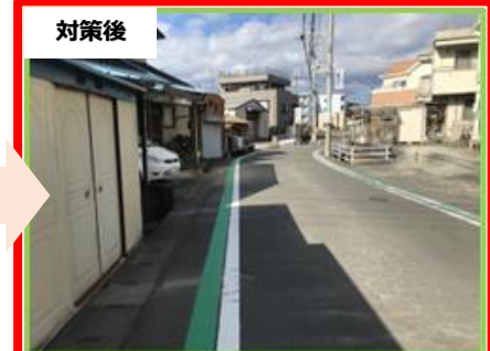
通学路安全対策アドバイザーの助言のもと、白線とグリーンベルトの設置位置を変更したことで車両からの視認性が向上した。
