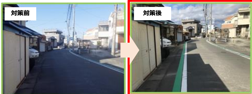
通学路安全対策アドバイザーの助言のもと、白線とグリーンベルトの設置位置を変更したことで車両からの視認性が向上した。
