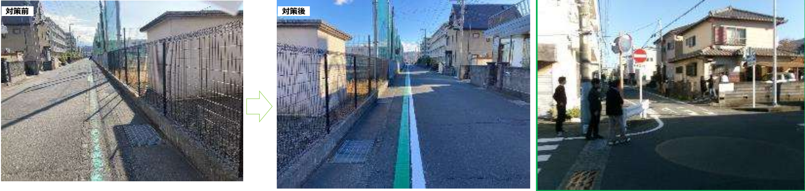
通学路のグリーンベルトを修繕
