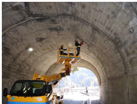
点検状況写真
