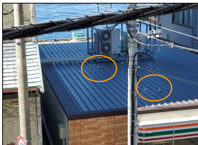
隣接する店舗の屋根落下した破片
