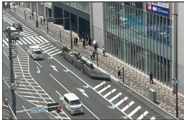
駅前道路のパークレット整備
