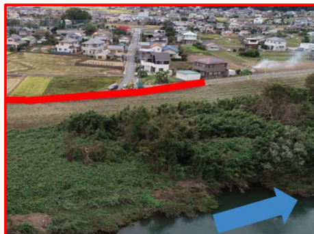
狩野川堤防整備(国)
