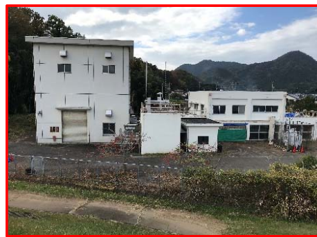
大平徳倉排水機場のポンプ遠隔操作装置等の導入(県)
