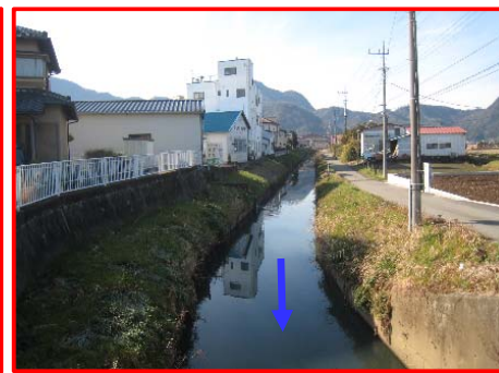
大平江川河道拡幅・護岸整備(市)
