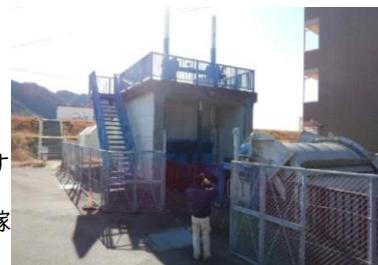
・ポンプ能力は、計画降雨時に床上浸水をなくすものとして決定 (TP6.15m)
