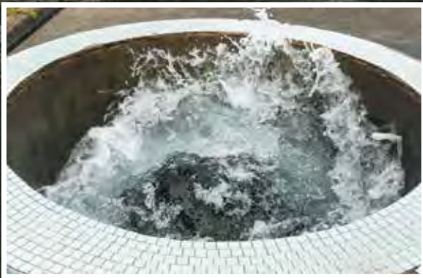
水が勢いよく湧き出ている様子（深井戸の蓋を開けたとき）
