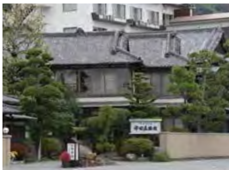
3つ連なる瓦屋根が特徴の安田屋旅館。手前2つの客室が松棟、奥が月棟。
