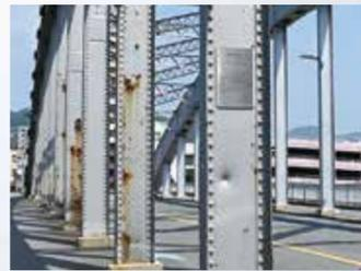
御成橋には1945年4月11日の爆撃による傷跡が残っています。爆弾が落とされ、爆風により破壊されたものが衝突した跡です。
