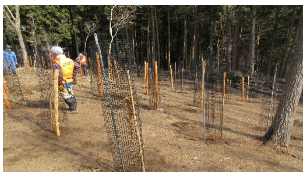
防護ネットを設置した後の様子
