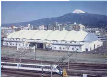
キラメッセぬまづ開館 平成10年(1998)10月
