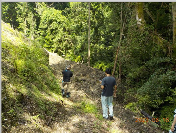
県市が連携して盛土量の計測を行う
