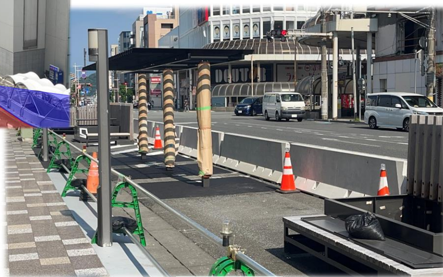
工事中的様子
