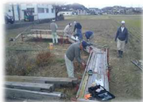
見学通路の設置
