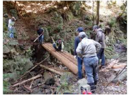
丸木橋の整備
