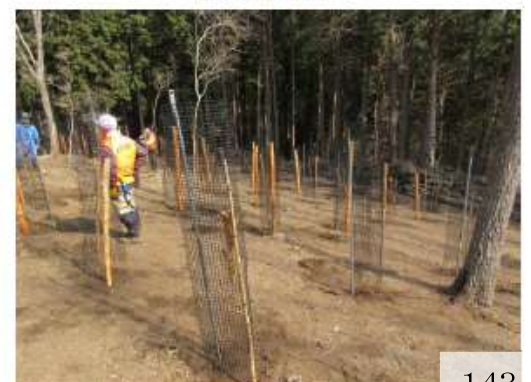
防護ネットを設置した後の様子
