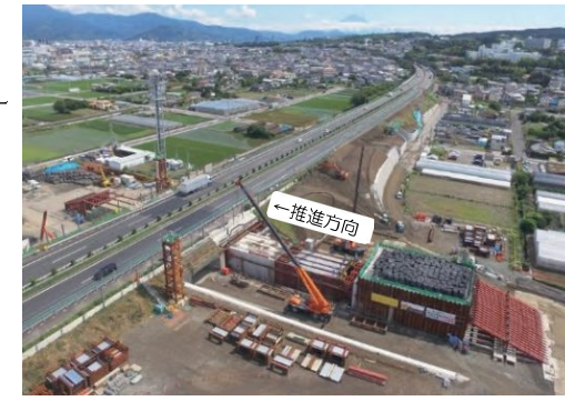
SFT工法施工事例 (東名高速 静岡東スマートIC 2019年9月開通)
