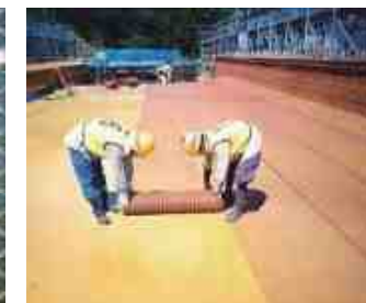
SAMM シートの敷設
