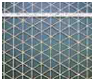
型枠にセットし、コンクリート打設時に表面にメッシュを貼り付け（一体化）
